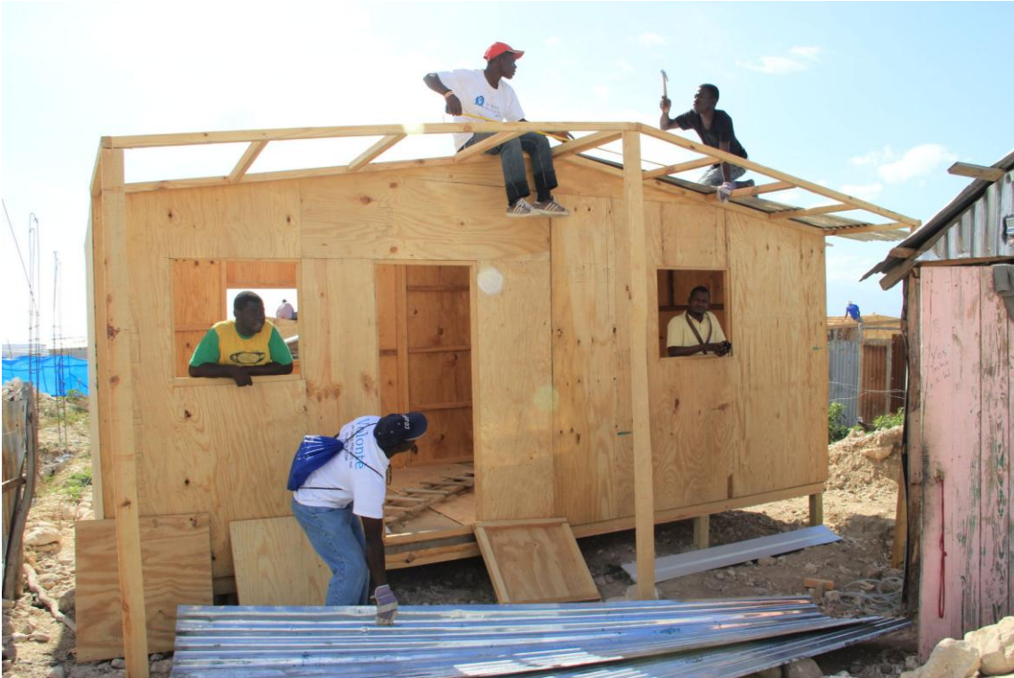
Vivienda tipo de 18m 2 construida en dos días por ocho voluntarios.
