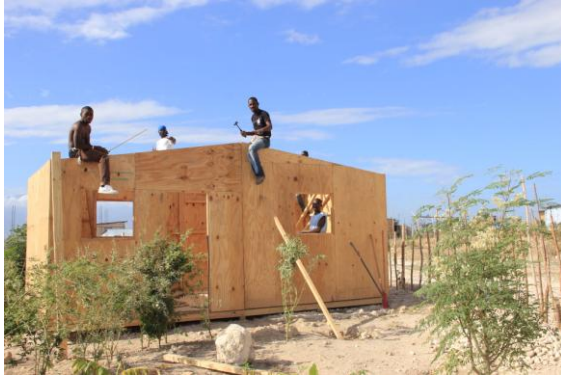
Construcción de viviendas entre familias beneficiarias y jóvenes voluntarios universitarios.
