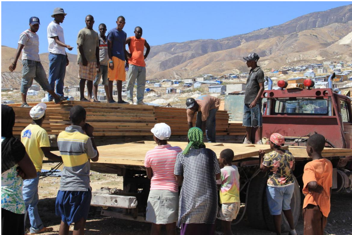
Llegada de materiales de construcción a Canaán para su posterior distribución entre las familias beneficiarias.
